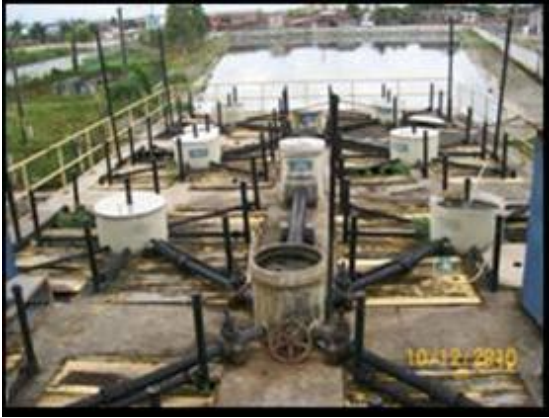
Figura 10 - ETE Mangueira (Reator e Lagoa)
