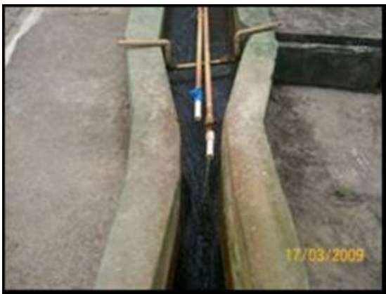
Figura 4- Sulfato aplicado na calha parshall pontual
