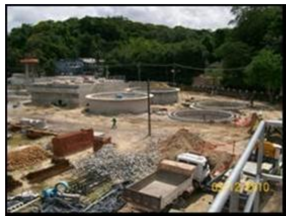
Figura 13 - ETE Minerva em construção
