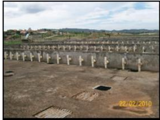
Figura 11 - ETE Vitória (Reator e Lagoa)
