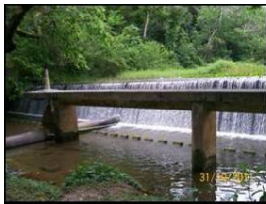
Figura 2 - Barragem em área de preservação
