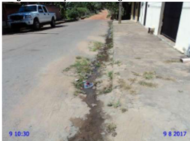
Figura 9 – Lançamento de esgoto à céu aberto
